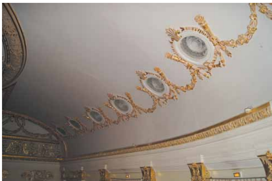
Рис. 1. Приточные диффузоры в отверстиях свода
