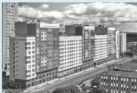
ЖК «Фестиваль», г. Уфа, 2014 год (система фасада – «Премьер», материалы облицовки – керамогранит, фиброцементные плиты, композитные панели)
