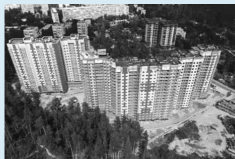
ЖК «Горки-10», Московская область, 2016 год (система фасада – «Премьер», материал облицовки – керамогранит)
