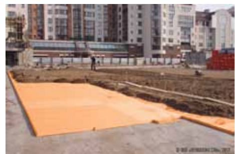
© ООО «ПЕНОПЛЭКС СПб», 2017 г. Рис. 1. Устройство эксплуатируемого покрытия 1. Балластный слой 2. Песчаная подушка 3. Дренажный слой 4. ПЕНОПЛЭКС® 5. Геотекстиль 6. PLASTFOIL®Geo 7. Геотекстиль 300 г/кв. м 8. Железобетонное основание
