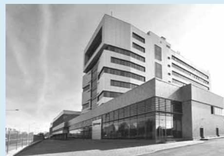
Офис СКБ-Контур, г. Екатеринбург, 2015 год (система фасада – «НордФокс», «Хилти», материалы облицовки – терракотовые плиты, кассеты из композита, солнцезащитные ламели)
