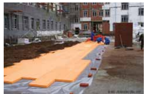
Рис. 2, 3. Пример использования теплоизоляции ПЕНОПЛЭКС® при строительстве эксплуатируемых покрытий
